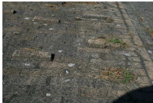
Willem de Zwijgerlaan – bestratingswijze (steeds één klinker hoger) bemoeilijkt onkruidbeheer
