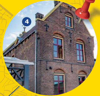
Gemeentelijk monument SPOORLIJN EN STATIONSWONING (WELKOOP) Parallelweg 3, 3931 MS Woudenberg
