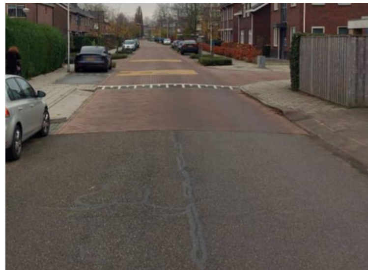
Asfalt wordt klinkers (W. de Zwijgerlaan)
